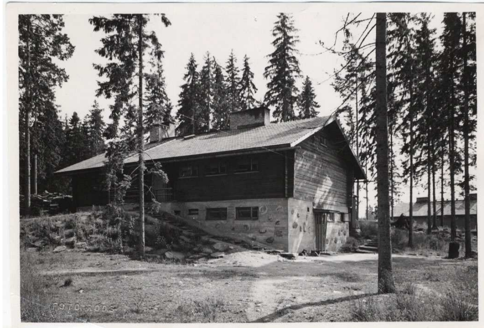
Kuvassa Alvar Aallon suunnittelema saunarakennus. Kuva Ahlströmin arkisto.
